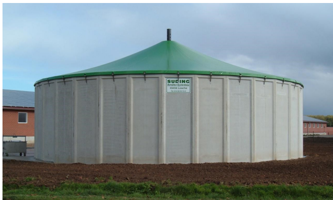
➌ Рис. 6: Блочный резервуар.
