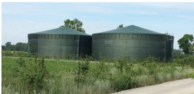
➍ Рис. 7: Резервуар из нержавеющей стали.
