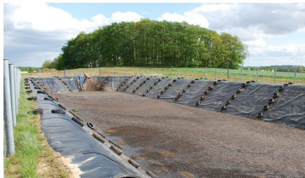
➊ Рис. 4: Земляная лагуна (пленочная лагуна).
